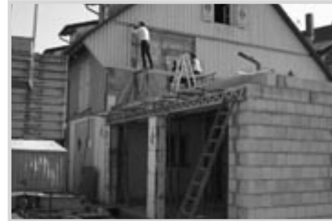
Impressionen von der Baustelle
