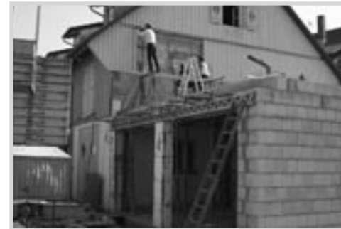
Impressionen von der Baustelle
